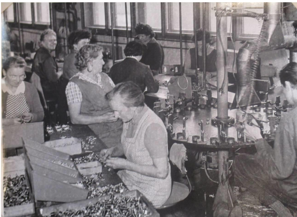
Obr. 7: Sestavování kataraktových jističů na točícím se pásu (50. léta 20. století) Převzato z: AO HK, f. OEZ s. p. Letohrad 1945–1958, I. část, sign. I/720, kart.18.
