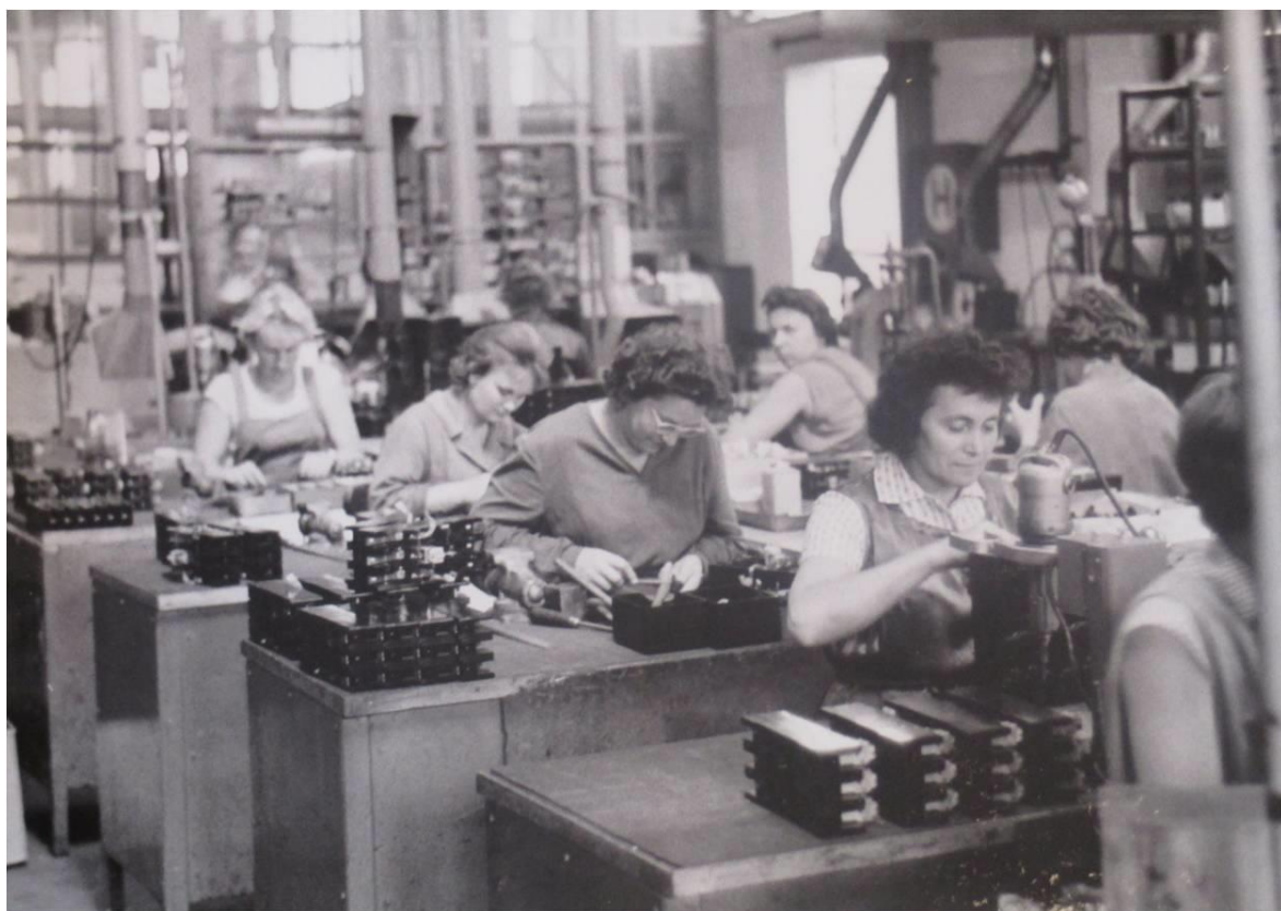
Obr. 41: Montáž deionových jističů
