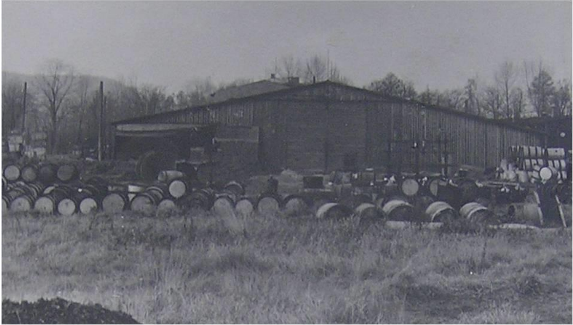
Obr. 39: Nevyhovující uskladnění sudů z hořlavinami (počátek 50. let 20. století) Převzato z: AO HK, f. OEZ s. p. Letohrad 1959–1991, II. část, sign. I/132, kart.9.
