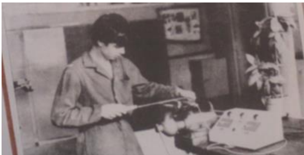
Obr. 51: Učeň při nácvičování pilování rovinných ploch na učební pomůcce "trenažér" (vedle svěráku) Převzato z: AOHK, f. OEZ s. p. Letohrad 1945–1958, I. část, sign. I/720, kart. 18.
